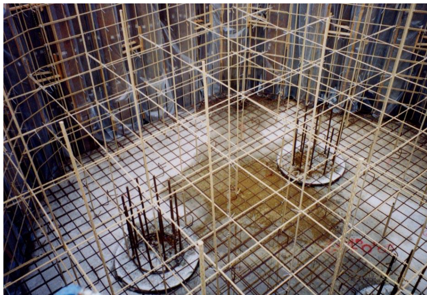
900MHzNMR 基礎配筋
