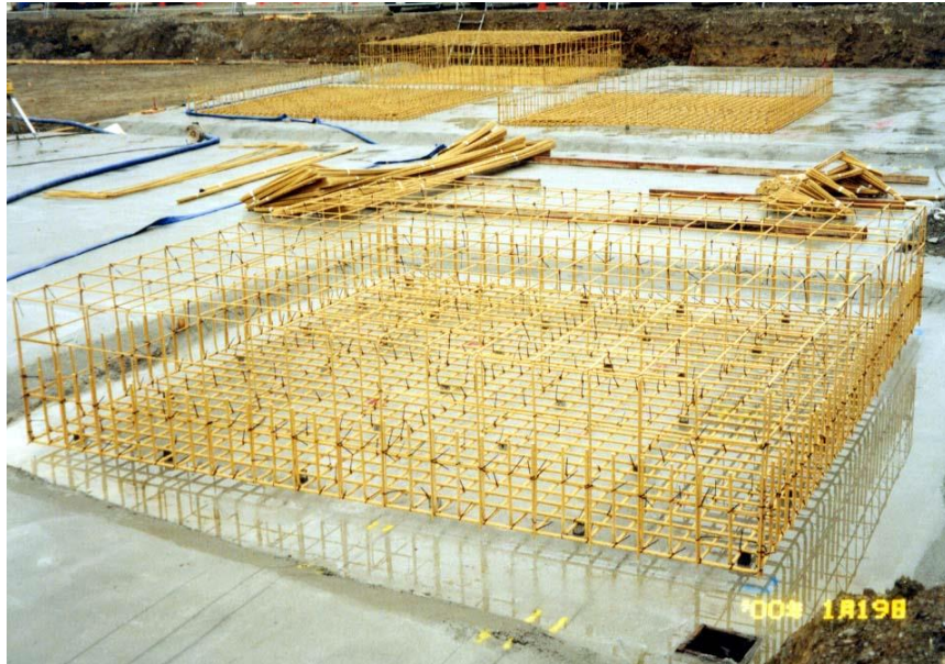
免震基礎配筋 (15mmS)
