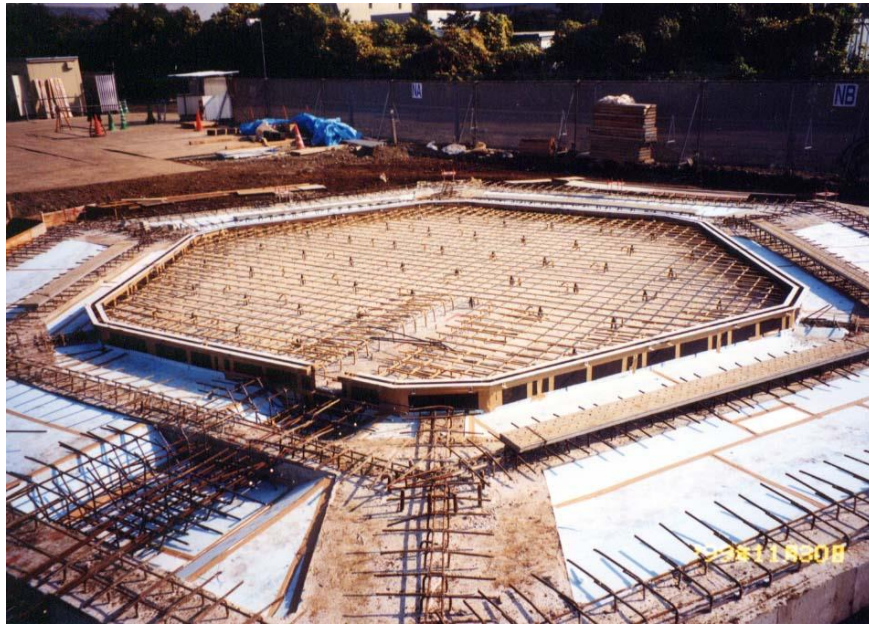
NMR 基礎配筋
