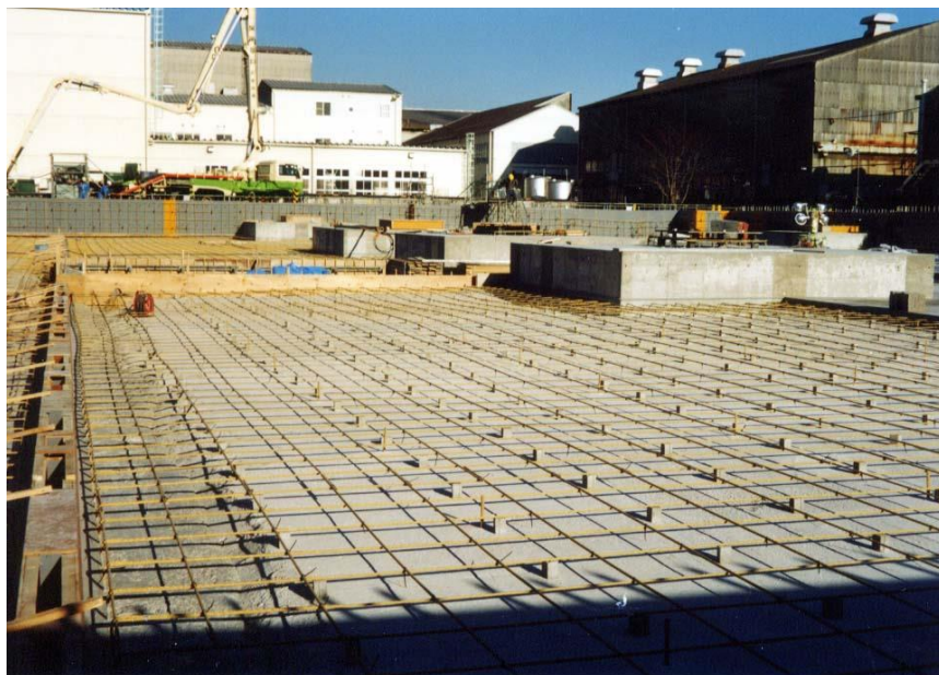
基礎底盤配筋 (9mmS)
